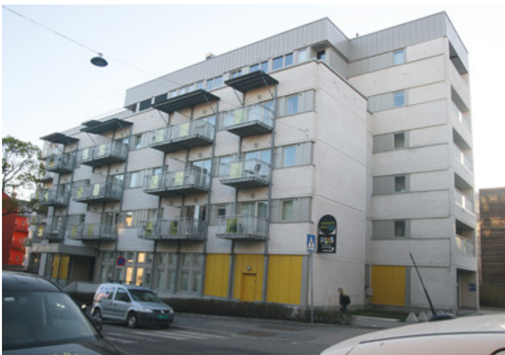
Sandakerveien 74 hvor det er avdekket en rekke feil og mangler – også feil som vil ha betydning for brann sikkerheten til beboerne.
